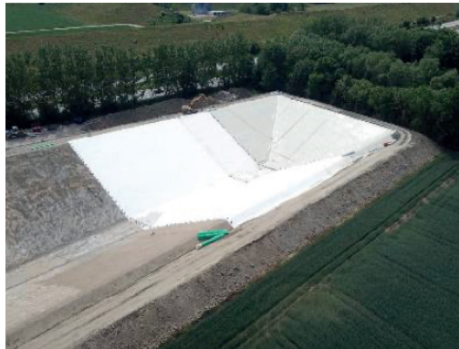
Abbildung 56: Diffusoranschluss (links); Verlegung des Liners in Høje Taastrup (rechts) (Quelle: Gquadrat)
