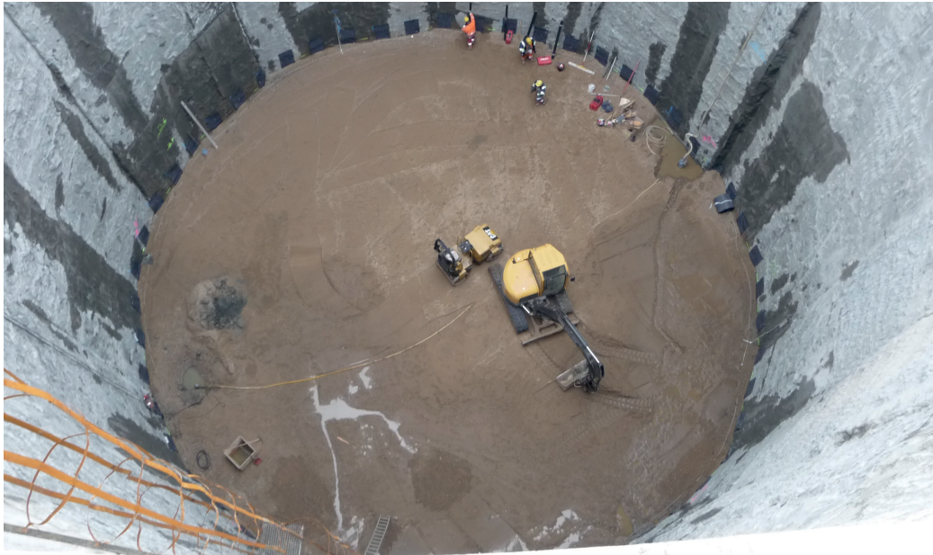
Abbildung 8: Fertige elliptische Schlitzwand - [©PORR]
