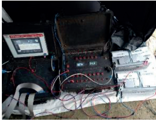
Abbildung 55: Prüfung des Baseliners auf Dichtheit in Høje Taastrup (Quelle: Gquadrat)
