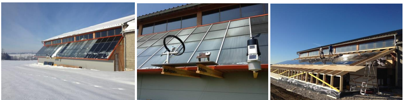
Abbildung 4 (links): altes Solarfeld; (mitte): Messtechnik zur Vorabprüfung der Messergebnisse - Mess-Station Outdoor; (rechts): Neues Kollektorfeld zur Realisierung unterschiedlicher Verschaltungskonzepte bei der Firma CONA
