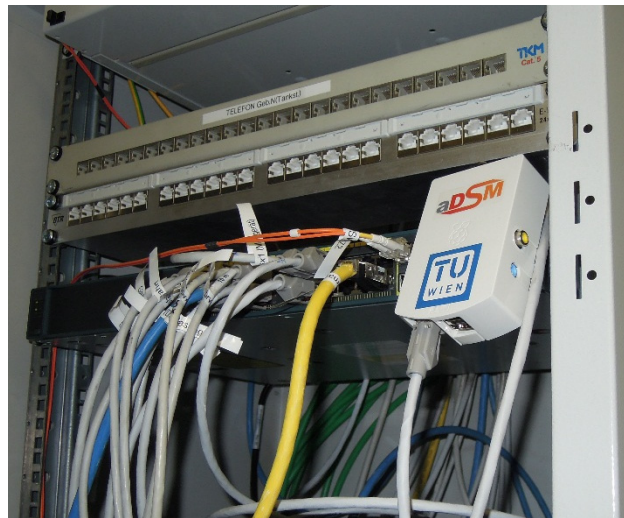
Abbildung 127: Foto des Installationsaufbaus der Controllereinheit in der Demo-Umsetzung
