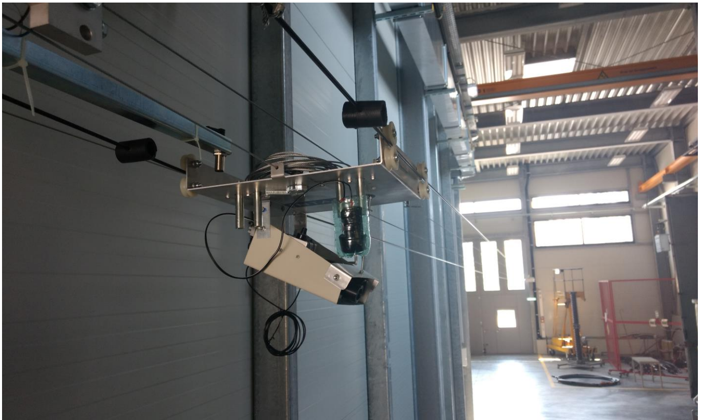
Abbildung 13: Sensormesskopf installiert am Hochgeschwindigkeits-Seilzugsystem
