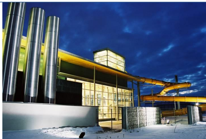
Abbildung 14: Außenansicht Hallenbad (Quelle: IFP – Immobilien Freizeit Parken)
