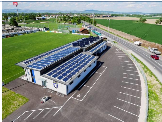
Abbildung 3: Thermische Solaranlage und PV-Module auf der Sonnenarena (Quelle: Raffael Portugal)
