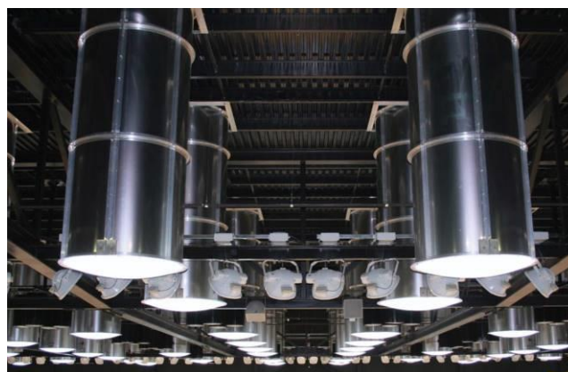
Abbildung 9: Lichtröhren, Copper Box Arena (Quelle: Populous Architects)
