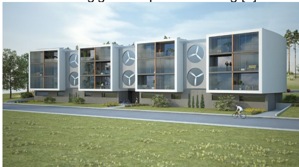
Abbildung 2: strömungsoptimierte Form der Gebäude unterstützt die Windausbeute der gebäudeintegrierten Windturbinen ( http://www.ea-gmbh.de )
