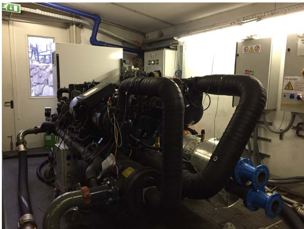
Abbildung 7: Zweistufiges HTWP Funktionsmuster am OCHSNER IWP Prüfstand, Ansicht Rückseite (Quelle: Ochsner Wärmepumpen GmbH / Ochsner Energie Technik GmbH.)
