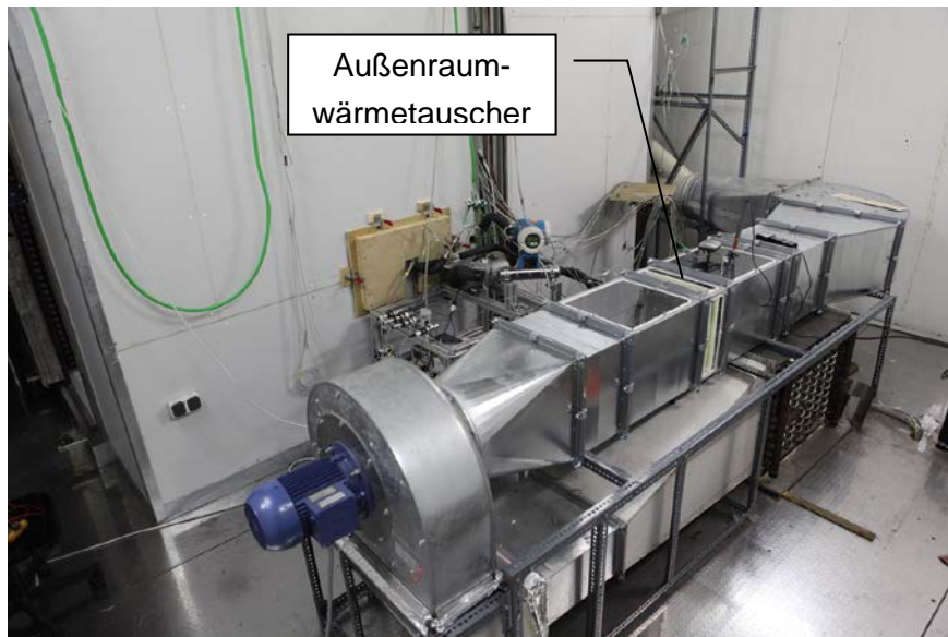
Abbildung 9: Luftkanal und aufgebaute Anlage in der äußeren Kammer
