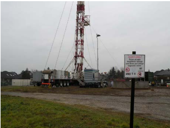
Abbildung 5: Beginn des Sondenumbaus
