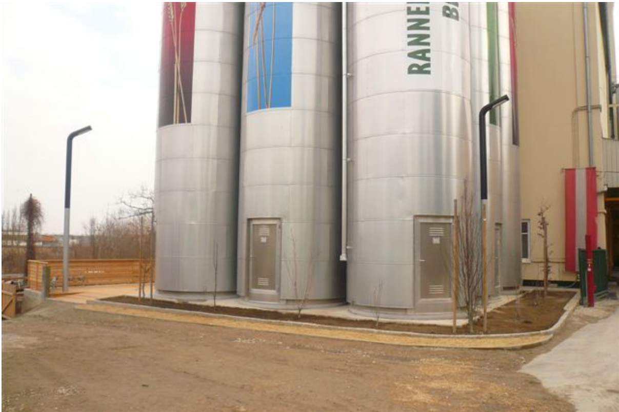
Abbildung 7: Mira 190 im Außenbereich der Biomühle Rannersdorfer
