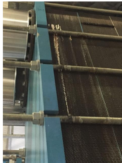
Abbildung 23: Wärmetauscherblech mit Scalingbelag, Rechts: Austritt von Natriumchlorid aus einem Wärmetauscher nach Kristallisation im Dichtungsbereich (Dichtung durch Kristallbildung schrittweise deformiert, zunehmende Undichtigkeit)
