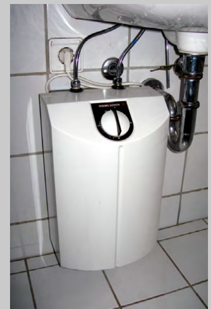
Dezentrale Warmwasser- Boiler/Speicher
