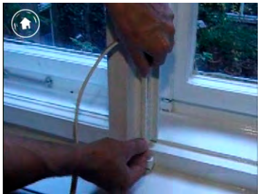
Dichtungsband über die ganze Länge des Fensters einkleben
