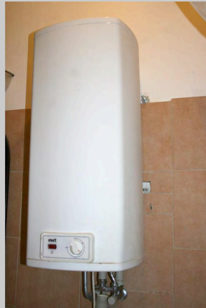
Zentrale Warmwasser- Boiler/Speicher
