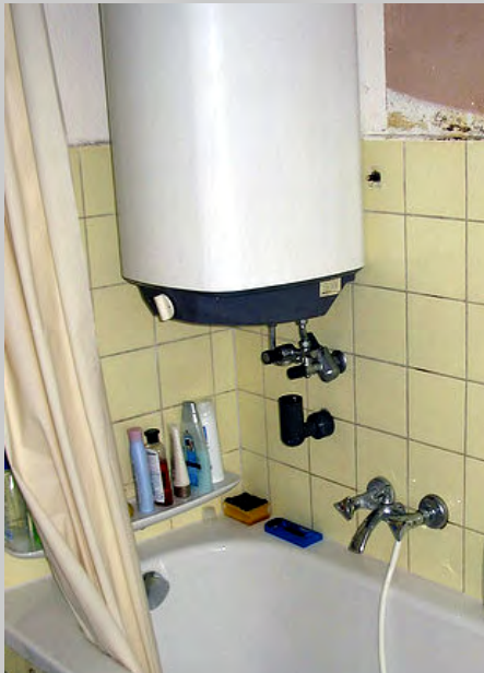
Zentrale Warmwasser- Boiler/Speicher
