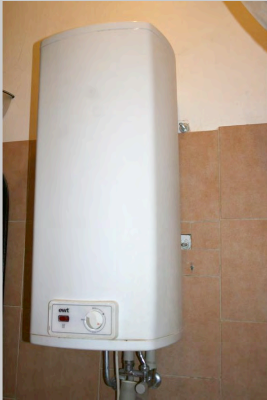
Zentraler Elektroboiler
