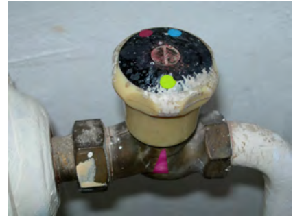
Altes Heizkörper-Drehventil mit Klebepunkten: rot = ganz geöffnet, blau = ganz aus, gelb = Mitte)
