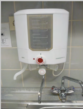
Dezentraler Elektroboiler
