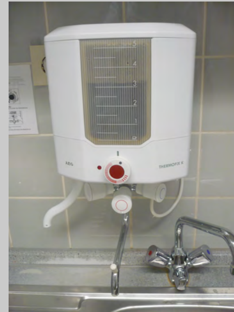
Dezentrale Warmwasser- Boiler/Speicher
