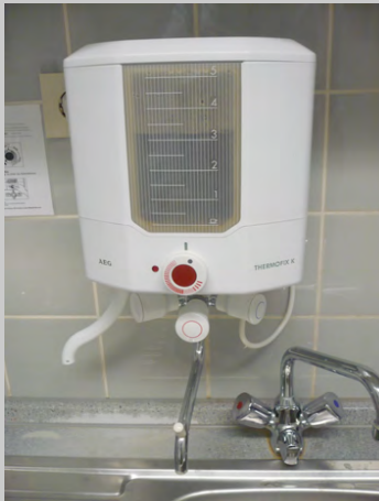
Dezentraler Elektroboiler
