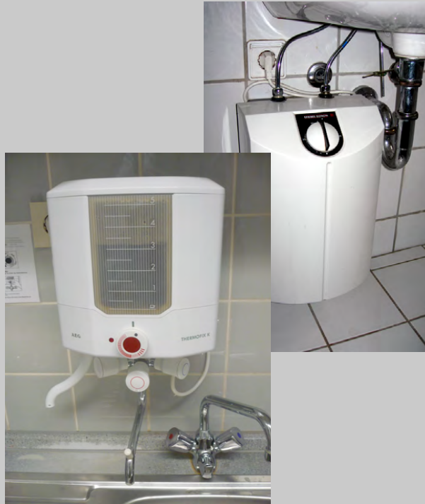
Dezentraler Elektroboiler/ Kleinspeicher
