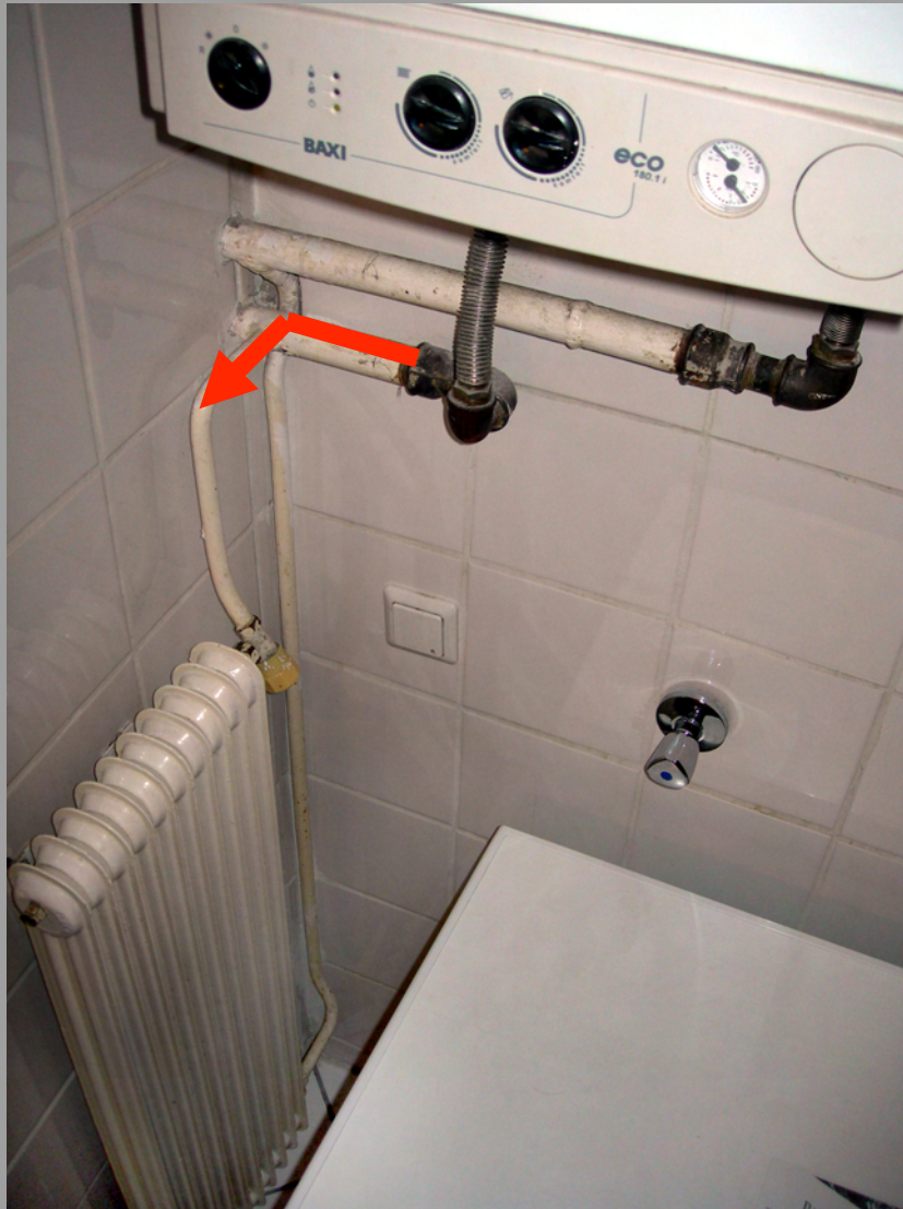
Erster Heizkörper in der Reihe: Im Bad, direkt unter der Therme
