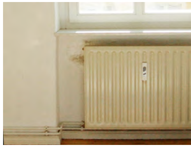
In Heizkörpernischen wenig beheizter Räume. Hinter den Heizkörpern sind die Mauern oft dünner als die übrigen Wandteile und die geringe Nutzung der Heizkörper fördert deren Auskühlung.
