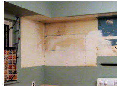
An Wänden hinter Möbelstücken, die an Außenwänden stehen oder hängen. Es fehlt hier oft eine ausreichende Luftzirkulation, die Feuchtigkeit aus der Wand aufnehmen könnte.
