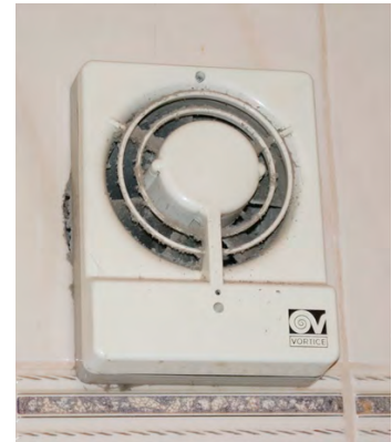
Verschmutzter Lüfter
