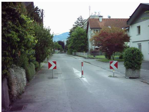
Abbildung 38: Beispiele für verkehrsberuhigte Straßen: links: Nebenstraße für Durchfahrt von Autos gesperrt (Feldkirch, Österreich, Foto: JAVUREK), rechts: „Kernfahrbahn“: Fahrbahn ohne Mittelstreifen mit beidseitigen Mehrzweckstreifen für Fahrräder; Autos fahren dadurch vorsichtiger und mehr in der Mitte (Niederlande, Foto: Ruud Ditewig, KERNFAHRBAHN)
