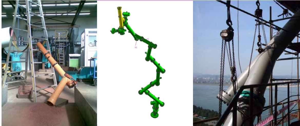
Abbildung 5: Umbau der Finex Anlage für einen Betrieb mit 3 Reaktoren
