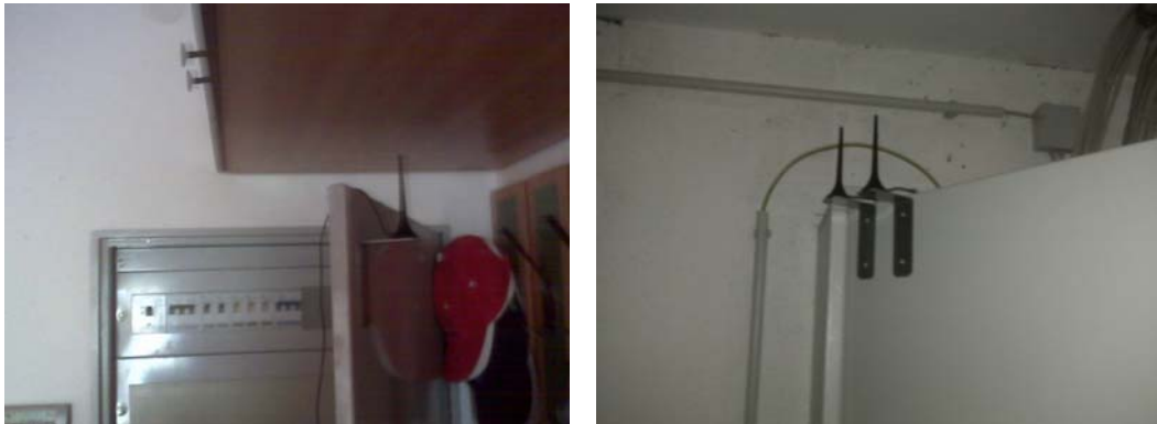
Abbildung 4: Externe Kommunikationsantenne
