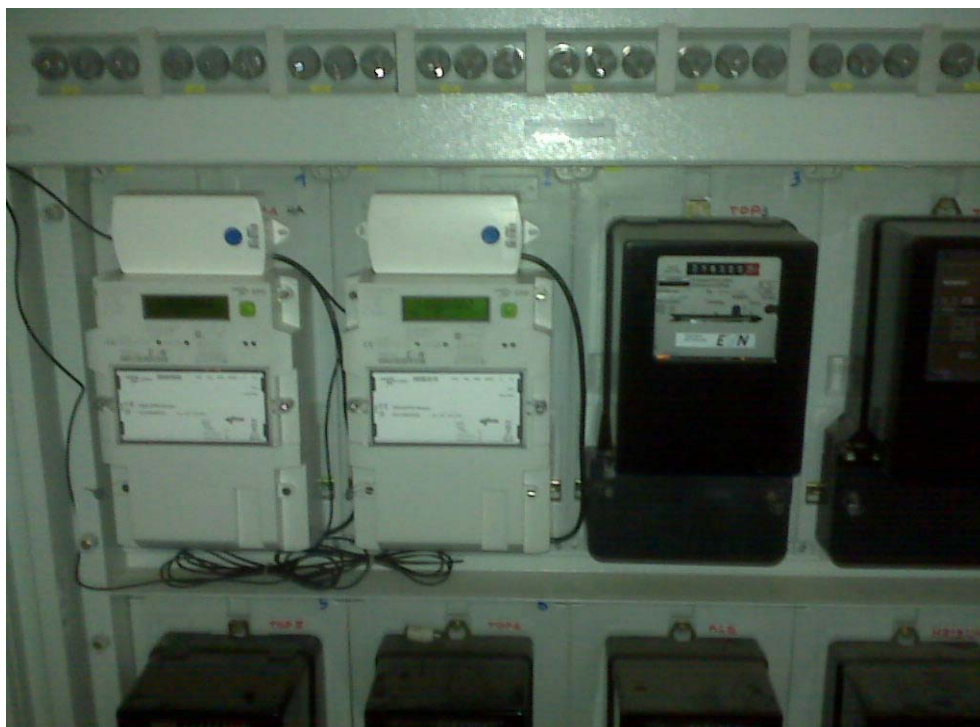
Abbildung 3: Einbaubeispiel Smart Meter
