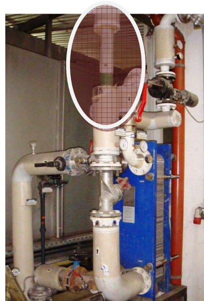
Abbildung 18: Messstelle „Pulverbeschichtung - Entfetten“ in Vorbereitung /AEE INTEC/
