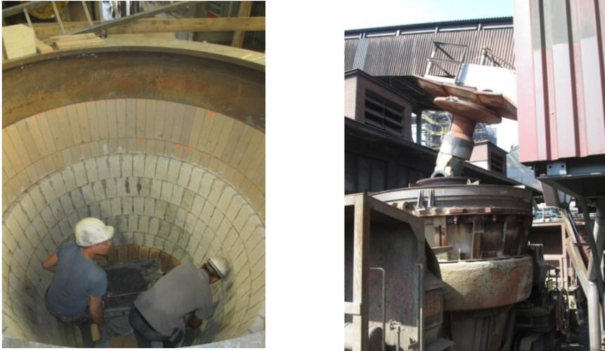
**Abbildung 9:** Modifizierte Schlackenkübel-Zustellung mit Feuerfestmaterial (links) und Aufheizung an bestehendem Torpedo – Brennerstand (rechts)
