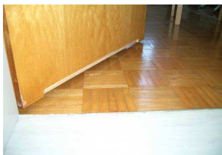
Abbildung 9.58: Ausnehmung bei einer Tür mit Anschlag (Sanierung)
