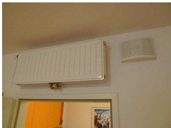
Abbildung 9.55: Heizkörper und Zuluftdurchlass über der Tür
