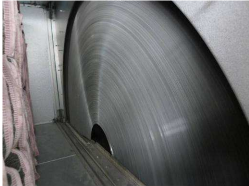
Abbildung 9.25: Rotationswärmetauscher zur Rückgewinnung von Wärme und Feuchte (ohne Kondensation)
