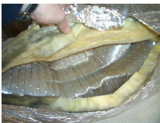
Abbildung 9.45 a und b: Ungeeignete und beschädigte Luftleitung aus Aluflexrohr bei einem Objekt außerhalb der Evaluierungsgruppe
