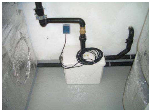
Abbildung 9.42: Hebeanlage für Kondensat
