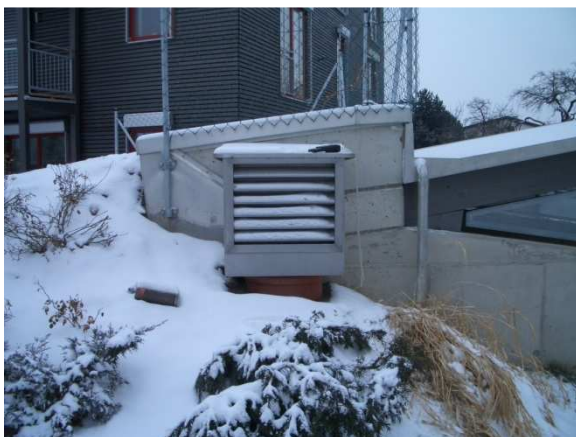
Abbildung 9.11: Außenluftansaugung in unzureichender Höhe und Abbildung 9.12: starke Verschmutzung des G4 Vorfilters. Verschmutzung noch von der Bauphase (Erdarbeiten).
