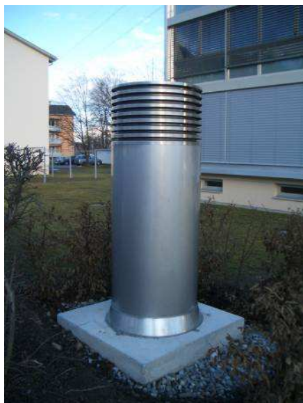
Abbildung 9.6 a und b: Außenluftansaugung und Fortluft in einem Turm führte zu Geruchsübertragung.
