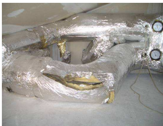
Abbildung 9.45 a und b: Ungeeignete und beschädigte Luftleitung aus Aluflexrohr bei einem Objekt außerhalb der Evaluierungsgruppe
