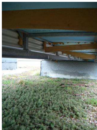
Abbildung 9.47: Luftführung im Kanal oberhalb des Daches
