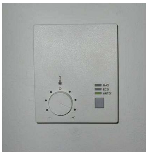
Abbildung 9.39: Kombinierte Bedieneinheit (Raumthermostat + Lüftungsstufe) für eine Luftheizungsanlage
