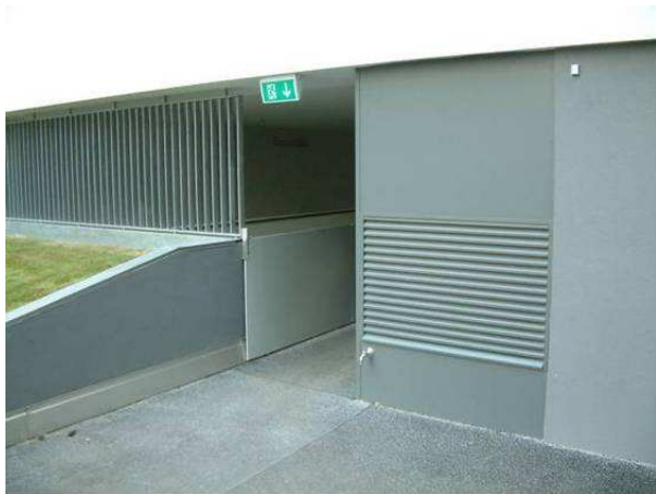
Abbildung 9.10: Außenluftansaugung in unzureichender Höhe
