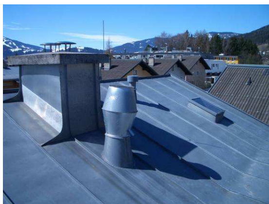
Abbildung 9.19: Einsteig zur Lüftung nur über Dachluke
