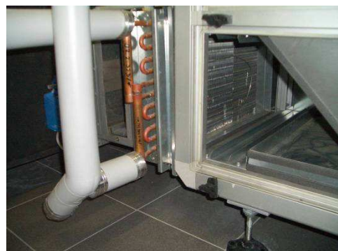
Abbildung 9.18: Anbindung des Wasser-Luft-Wärmetauschers (Heizung bzw. Solaranlage)
