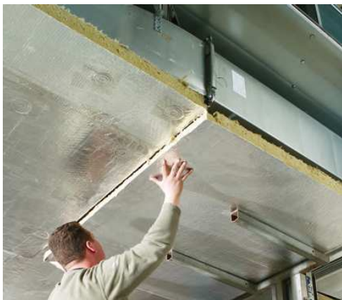
Abbildung 7.61: Bekleidung mit Brandschutzplatte; Quelle: Rookwool, Conlit
