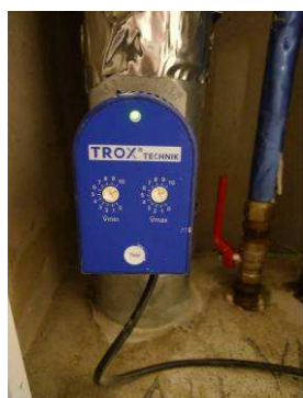
Abbildung 9.38: Volumenstromregler mit 2-stufiger Voreinstellung
