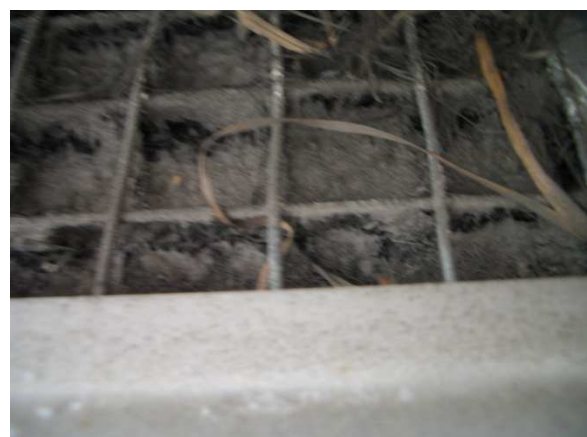
Abbildung 9.11: Außenluftansaugung in unzureichender Höhe und Abbildung 9.12: starke Verschmutzung des G4 Vorfilters. Verschmutzung noch von der Bauphase (Erdarbeiten).
