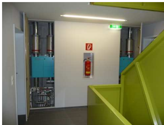
Abbildung 9.3: Stiegenhaus mit dezentraler Einheit
