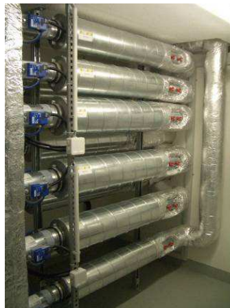
Abbildung 9.44: Sternsystem: ein Strang für jede Wohnung
