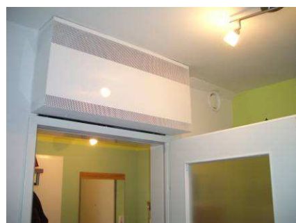
Abbildung 9.54 a u. b: Induktionskasten für Wohnzimmer-Küchenverband und danebenliegendes Abluftventil im Küchenbereich
