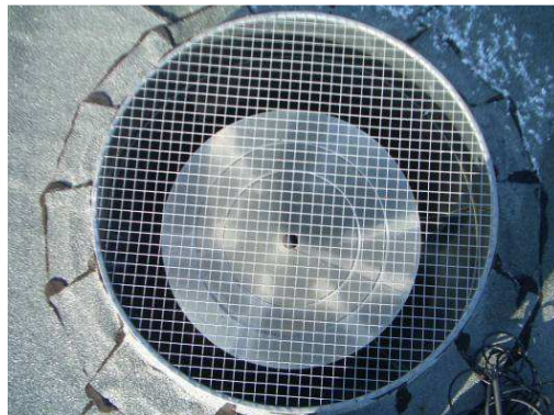
Abbildung 9.9 a und b: großzügige Ansaugung auf der Seite und Fortluft nach oben
