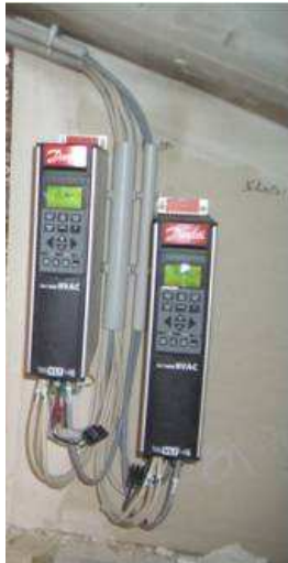
Abbildung 9.24: Frequenzumformer für Zuluft- bzw. Abluftantrieb
