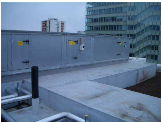
Abbildung 9.48: Luftleitung in die Außendämmung und die Außenabdichtung integriert.
