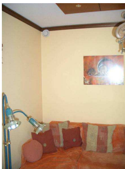
Abbildung 9.5: Falsche Ventilwahl (Radiusauslass) für die Zuluft in der Raumecke über der Couch
