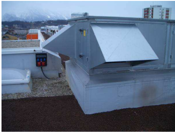
Abbildung 9.8: Außenluftansaugung und Fortluftführung
