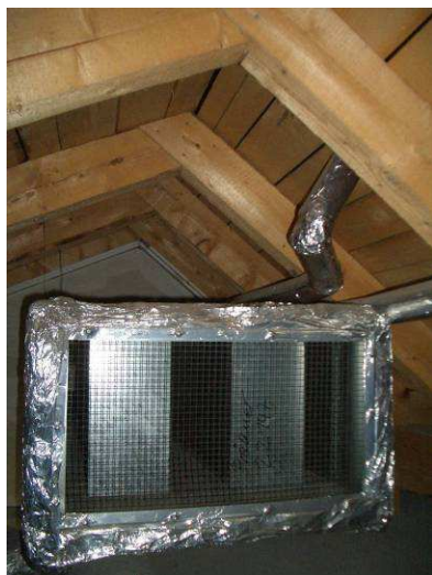
Abbildung 9.13: Außenluftansaugung unter dem Blechdach führt im Sommer zu unnötig hohen Temperaturen (deutlich über 40°C im Ansaugbereich)
