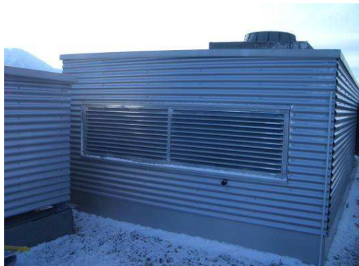
Abbildung 9.9 a und b: großzügige Ansaugung auf der Seite und Fortluft nach oben
