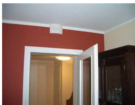
Abbildung 9.53: Induktionsauslass
