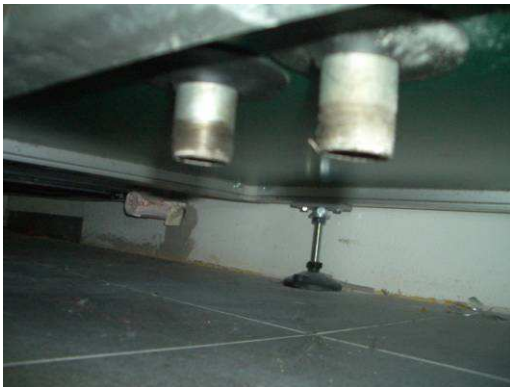
Abbildung 9.41: Fehlender Anschluss für Kondensat
