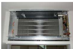
Abbildung 9.54 a u. b: Induktionskasten für Wohnzimmer-Küchenverband und danebenliegendes Abluftventil im Küchenbereich
