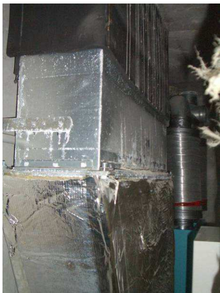
Abbildung 9.46: Fortluftleitung mit 3 unterschiedlichen Bereichen unzureichender Dämmung
