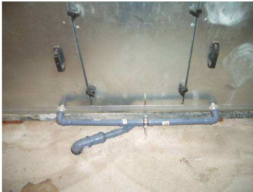
Abbildung 9.40: Kondensatablauf ohne Möglichkeit der Nachfüllung (Bodensiphon) und Leckströmung zwischen den beiden Wärmetauscherseiten.
