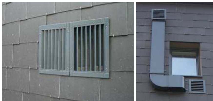
Abbildung 9.7 a und b: Außenluftansaugung und Fortluft vor und nach der Adaptierung
